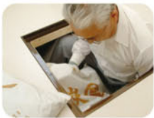
①ケースを外して床下に入る。
