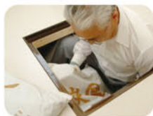
①ケースを外して床下に入る。
